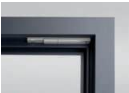
Kontaktron bezprzewodowy
