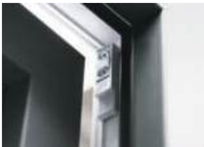
Kontaktron nawierzchniowy przewodowy
