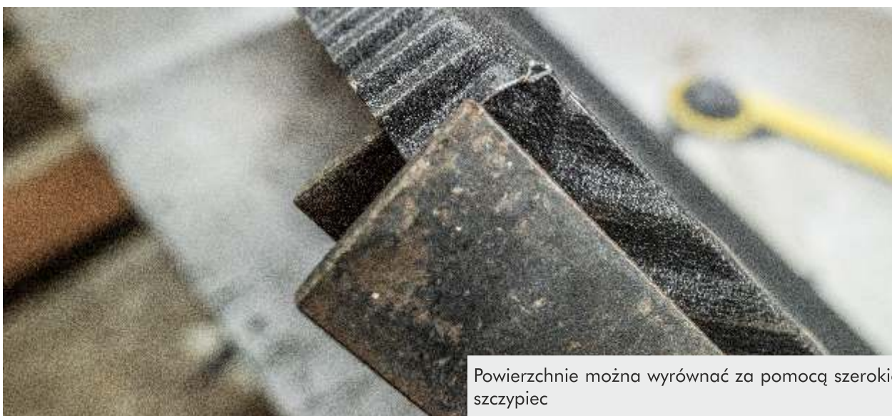
Czoło panela razem z dogiętą częścią boczną należy wyrównać poprzez obcięcie rogu
