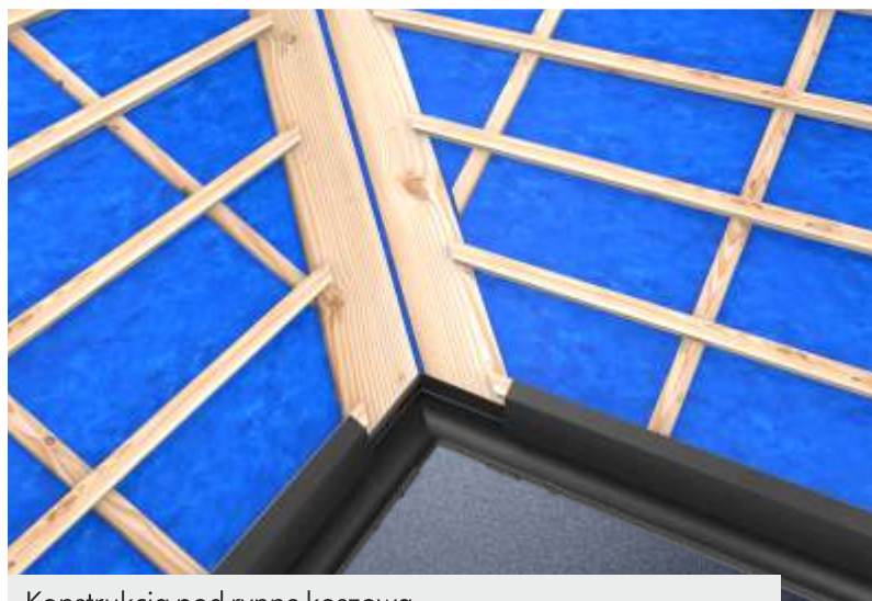
Konstrukcja pod rynnę koszową
